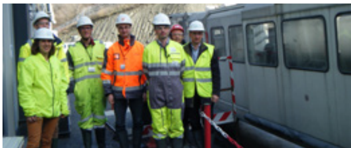
Le TELT - Descente au plus près des travaux du tunnel Lyon - Turin pour quelques privilégiés en avril, puis journée découverte en partenariat avec l'AFGC et l'AFTES fin septembre
